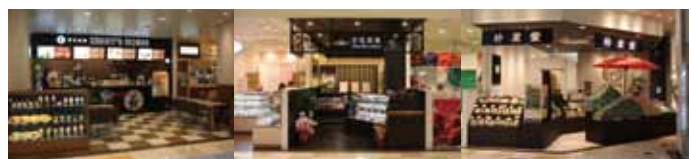
▲サントムーン柿田川 本館食品ゾーンリニューアル工事
