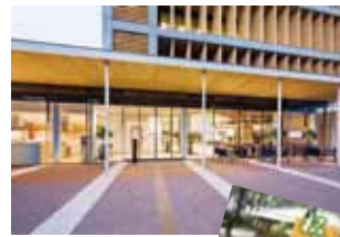
▲静岡ガス本社 ショールーム新設工事
